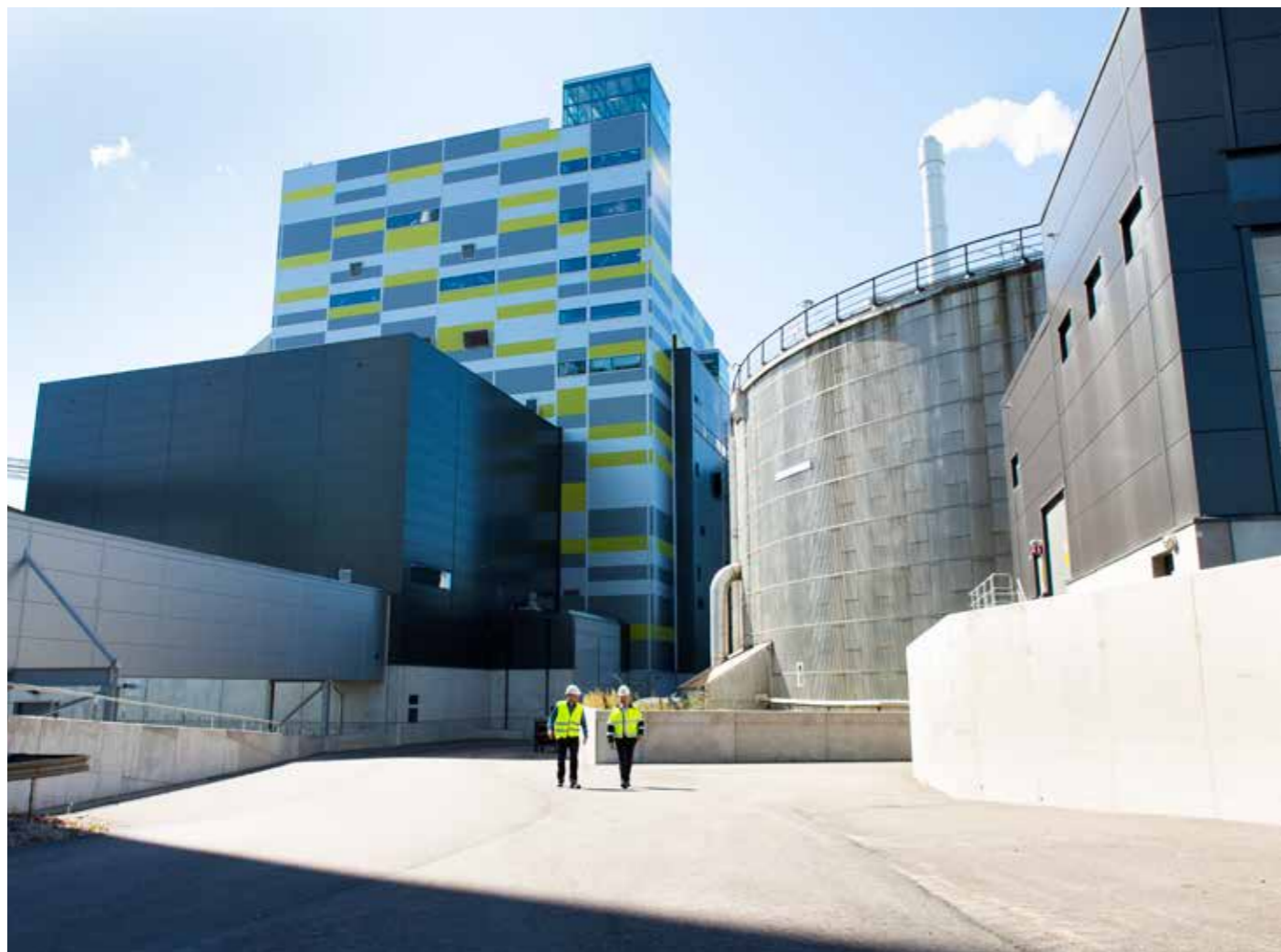
Block 6 hos Mälarenergi i Västerås invigdes 2014 och är helt och hållet optimerat för avfallsförbränning.
